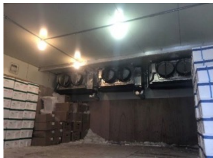
⑤ 大型水産倉庫 (埼玉県・大弘水産)
